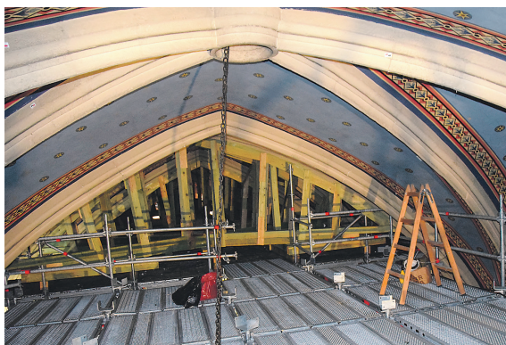
Slika 3. Presjek unutarnje skele sa zonama ojačanja i pogled na središnji dio u završnoj fazi montaže (projektant skela D. Skejić s najužim suradnicima I. Čudinom i A. Valčićem)
