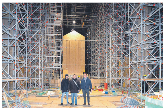
Slika 3. Presjek unutarnje skele sa zonama ojačanja i pogled na središnji dio u završnoj fazi montaže (projektant skela D. Skejić s najužim suradnicima I. Čudinom i A. Valčićem)
